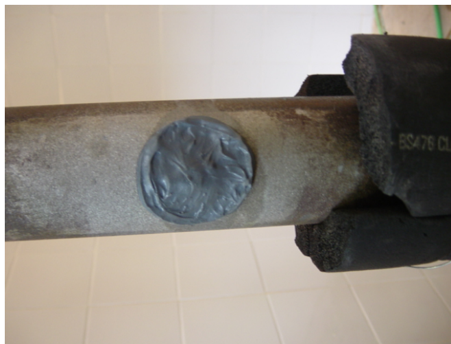
Fig. A.7. Detalhe do Reparo
