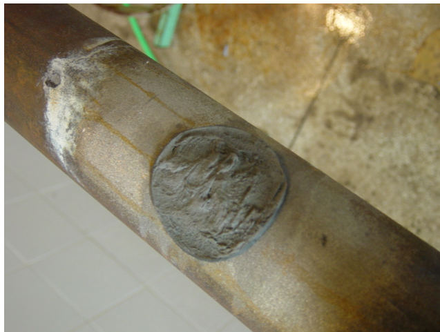
Fig. A.13 - Detalhe do Reparo. MM-METAL SS AÇO CERÂMICA
