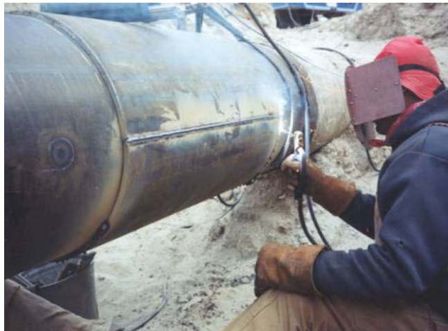
Figura 3.1 - Instalação de Luva tipo B
