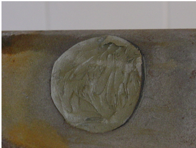
Fig. A.9 - Detalhe do Reparo. BELZONA 1111.
